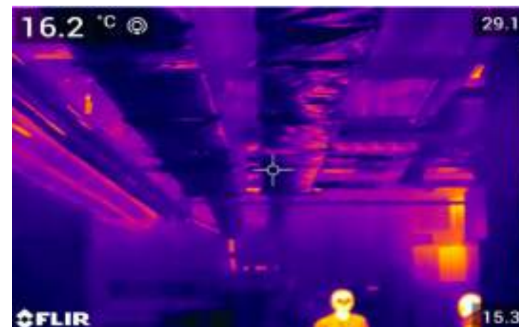
Condotte di ventilazione in uso al di sotto di canalizzazioni apparentemente non più funzionanti
