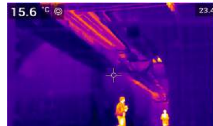
Condotte di ventilazione in uso posizionate al di sotto di condotti apparentemente non attivi
